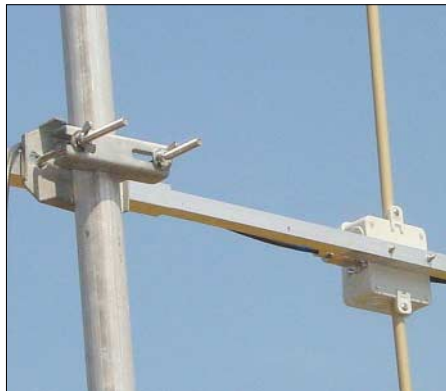
Bild 2: Ansicht der für Abgleichzwecke verschiebbaren Masthalterung
