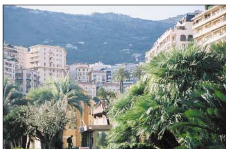
Der Blick auf Monaco verdeutlicht die beim Netzaufbau zu bewältigenden Probleme in dem zwischen felsigen Hügeln und Palmen gelegenen Mittelmeer-Fürstentum.
